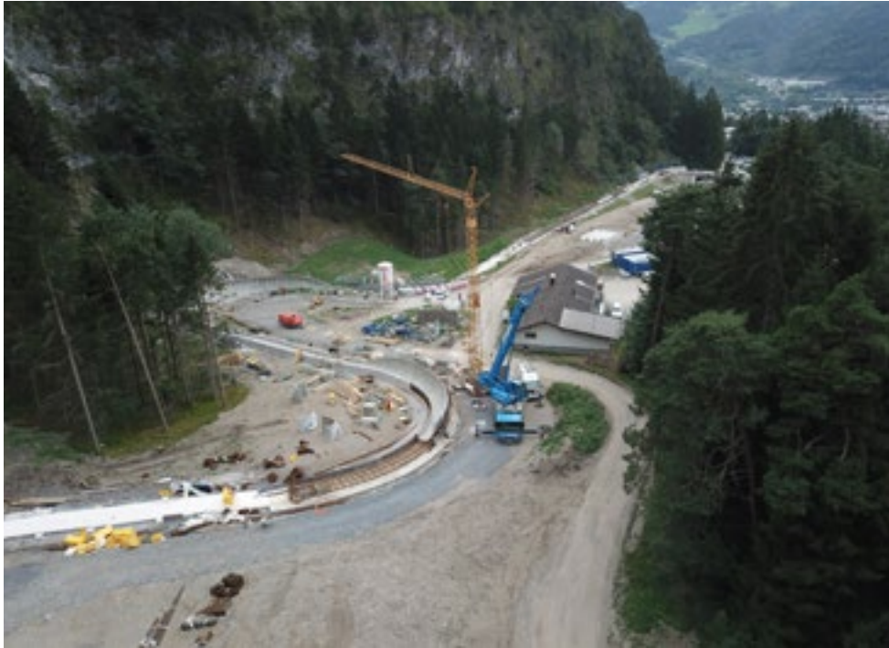
Eiskanal Bludenz während der Bauarbeiten im Jahr 2020.
